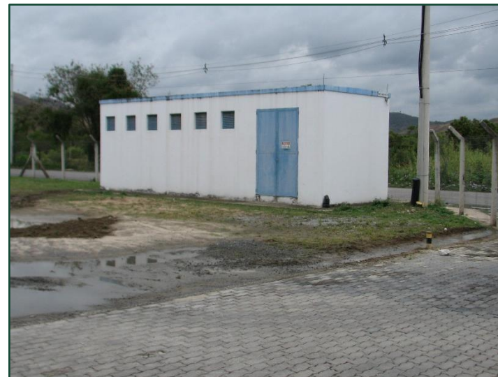
Casa de máquinas 2
