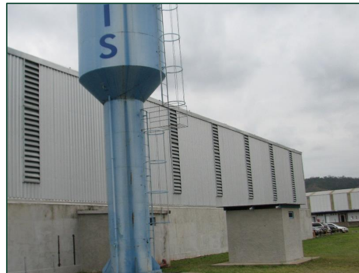
Fachada lateral do galpão e reservatório
