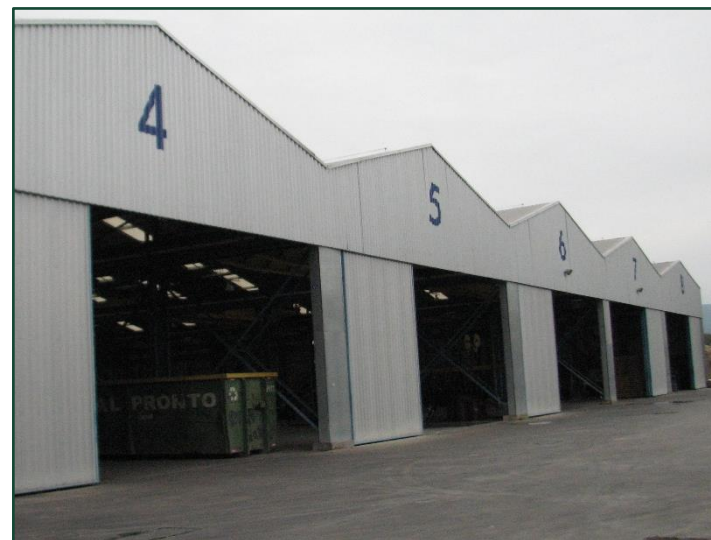
Entradas do galpão
