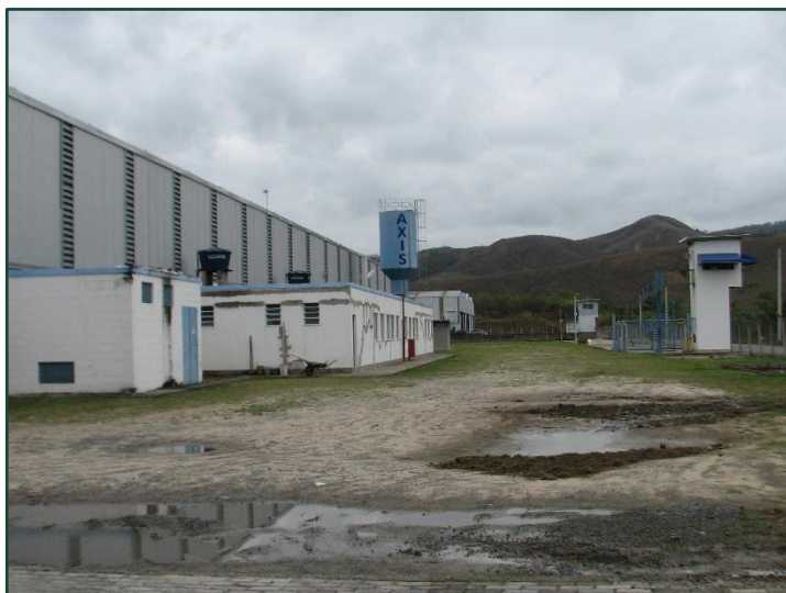
Pátio do galpão
