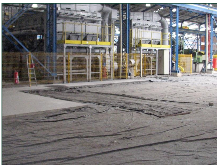
Vista interna do galpão
