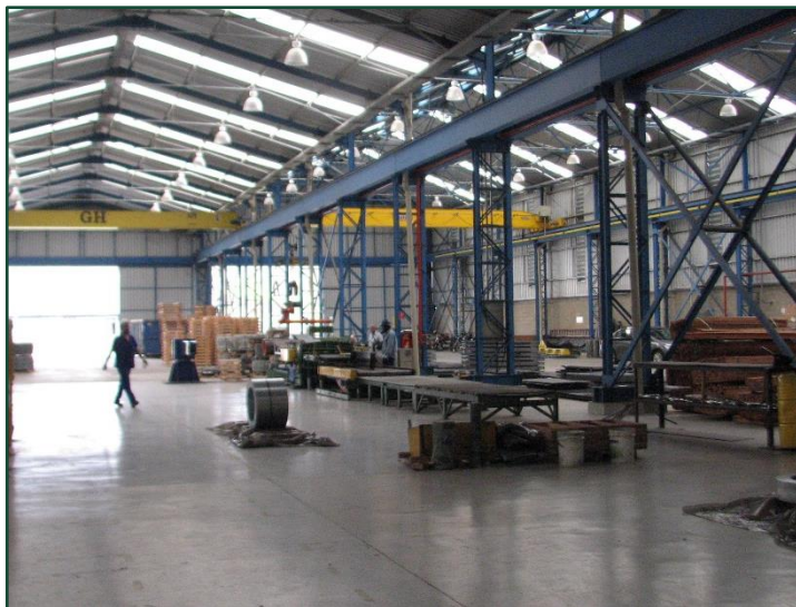
Vista interna do galpão
