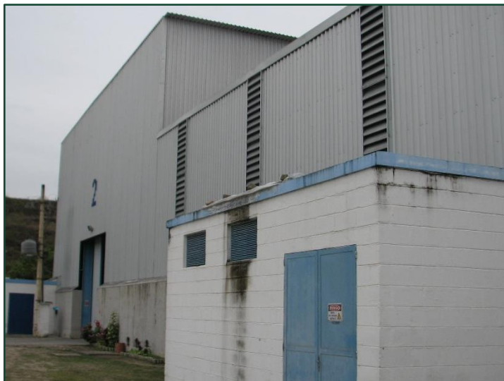
Casa de máquinas 1
