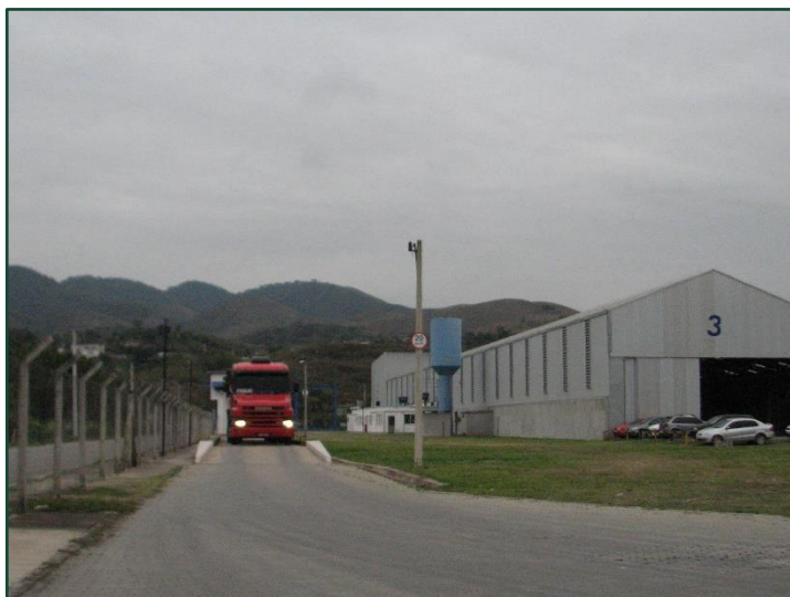
Vista da entrada de caminhões e balança
